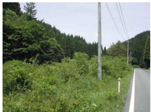
写真6. 湿原と国道の間には側溝が敷設され, そのときの残土置き場にはタニウツギの低木群落が発達していた (2002. 6. 8).
