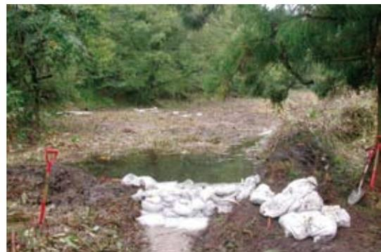
写真15. 第3堰堤により上沢田上流部の地下水水位が保たれるようになる (2004.9.23).
