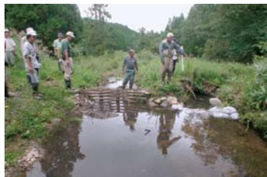
写真16. 最上流部に作られた堰. 右側は湿原への流路 (2005.9.23).
