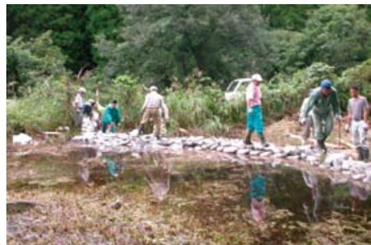
写真14. 第2堰堤の造築作業. 土囊を3段程度積み上げた (2004.9.21).
