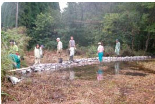
写真11. 第1堰堤の造築作業. 土囊を5段程度積み上げた (2004.9.21).
