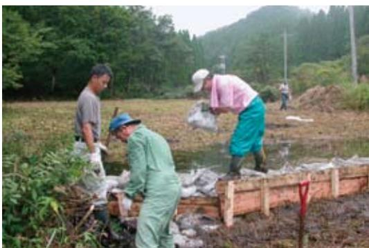
写真12. 堰堤は杭と板で補強した(2004.9.21).
