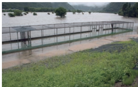
写真15. 新成羽川ダム放水後の最大冠水時 (2010.7.14)
