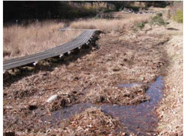
写真21. 水を上流から誘導して湿った状態を維持できるように土手などを造り、水を貯めるようにした(2010年12月12日).
