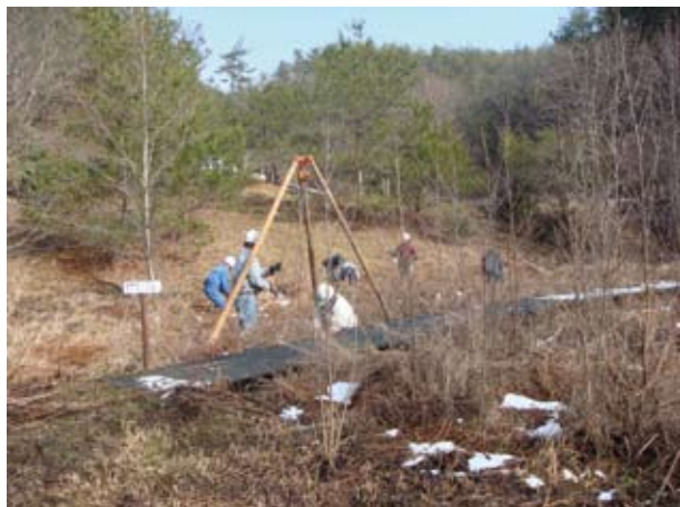
写真13. 滑車とチェーンを利用してハンノキをつり上げて除去した(2008年1月24日).
