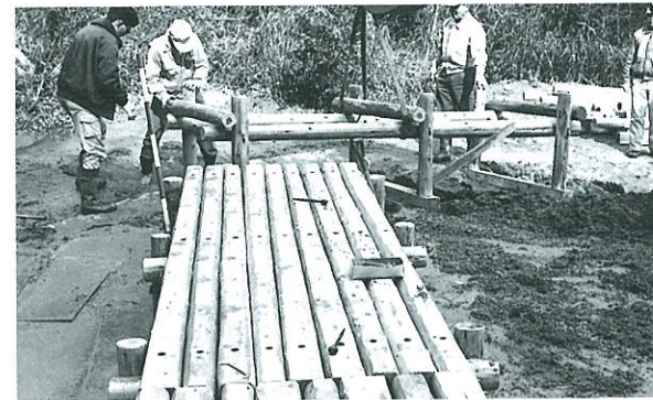
写真7. 木道の設置作業
