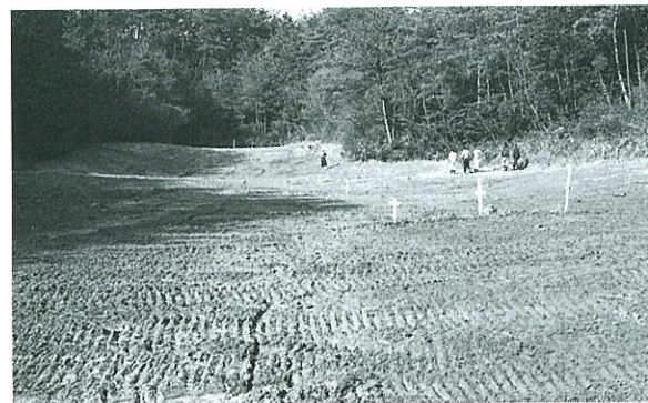
写真4. 造成直後の地形
