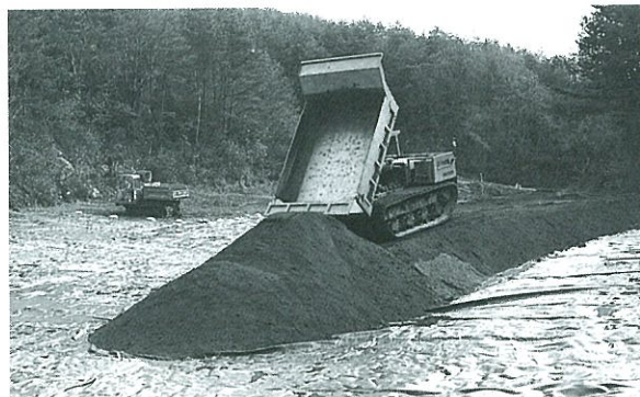
写真3. 表土 (マサ土) の搬入作業
