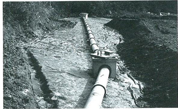
写真5. オーバーフローのためのヒューム管
