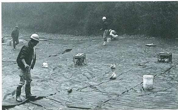
写真2. 防水シートの敷き詰め作業
