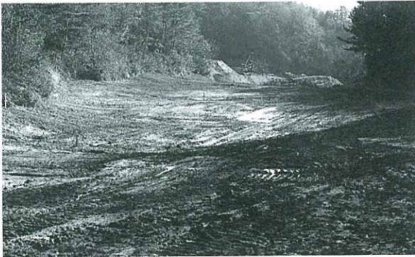
写真1. 水田土壌による造成直後の基盤地形
