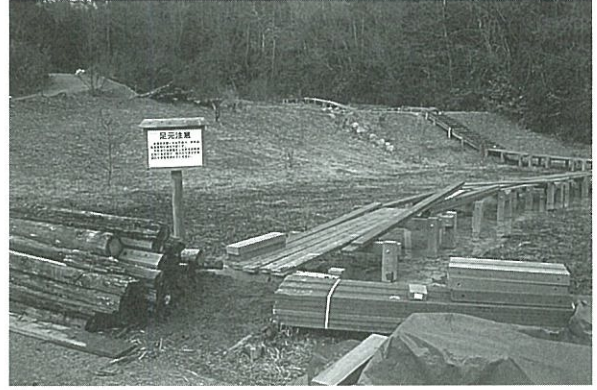
写真9. 木道の修理. 古くなった材料(左)と新しい材料(右). 看板は, 木道が腐ったため, 歩行に注意をうながすために設置したもの.
