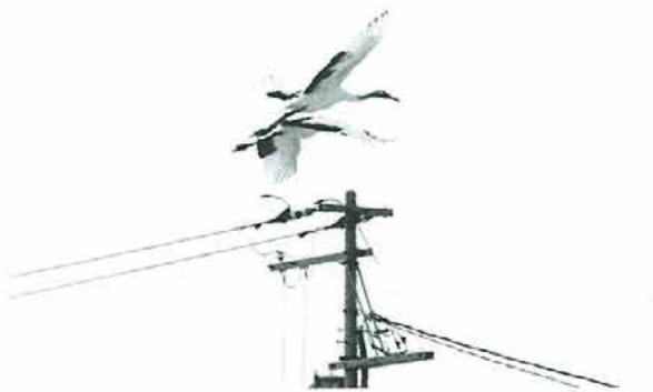
写真82. 電柱を避ける（1994年2月）
