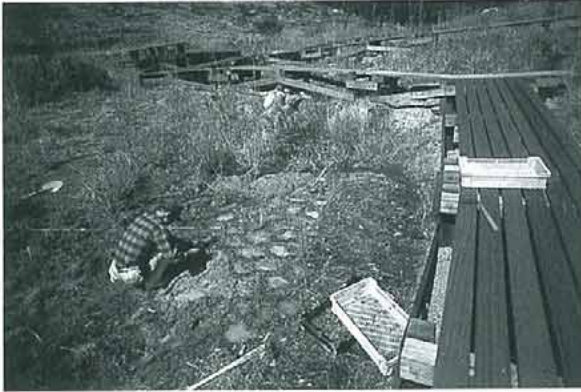
写真5. 西の谷の流路の補修. 流れが滞った場所でうろこ状植栽を行った(1998年4月10日撮影).
