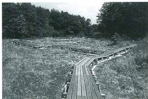
写真2. 西の谷に新設された木道の下にマサ土を入れた（1997年5月12日撮影）.
