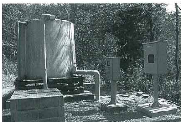
写真1. 井戸に設置された水量コントロールパネル（右端）（1998年3月30日撮影）.
