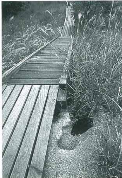
写真6. 台風時の大雨により逃げ場を失った水が本道の階段の下を流れた(1998年10月21日撮影).
