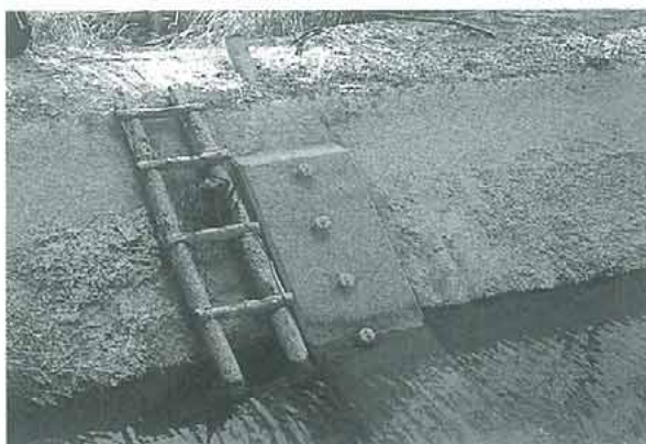
写真15. 西谷池の修理後, 新たに設置された樋(1997.2.10).
