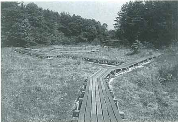
写真13. 木道の修理が終了した(1997.5.12).
