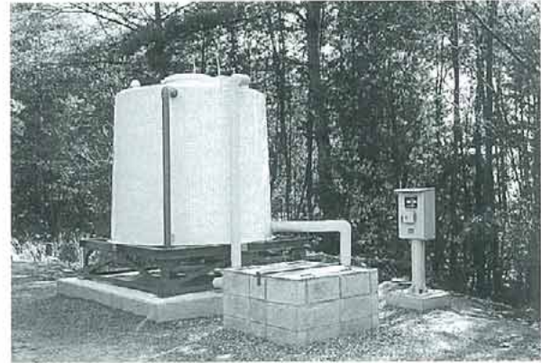
写真16. 完成した井戸の付帯設備. 汲み上げた水を一時貯蔵する容量の5トンのタンクと汲み上げを管理する分電盤(1995.2.16).
