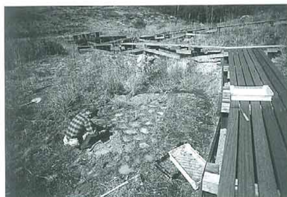
写真9. 西の谷での流路整備. 土砂で埋まった部分をうろこ形植栽で修理 (1998.4.10).
