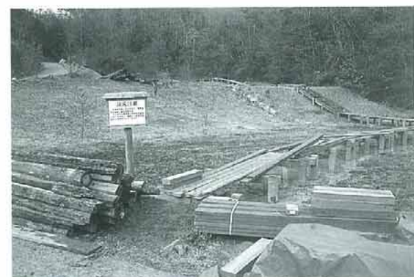
写真12. 木道の修理. 立入禁止にして工事を進めた (1997.3.6).
