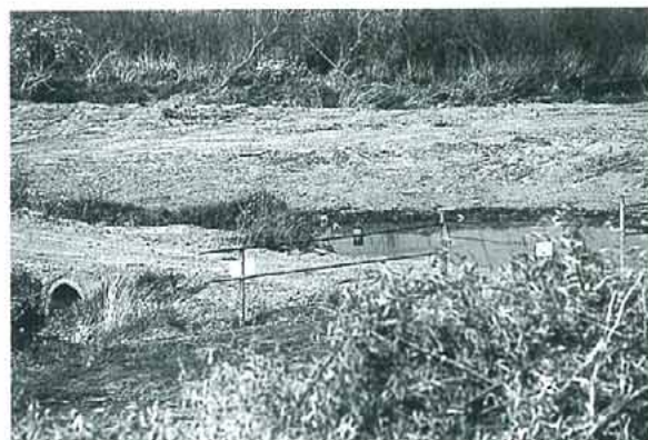
写真6. ヒューム管を利用して中州への進入路を確保する（2000.4）
