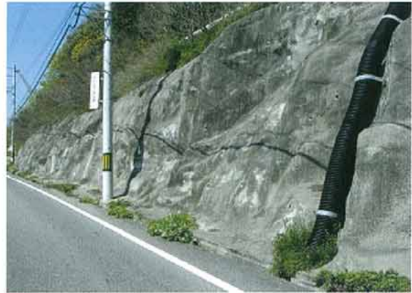
写真8. コンクリート吹き付けの例. 全く隙間がなくなると本種は産卵場所や隠れ場所を失ってしまう.
