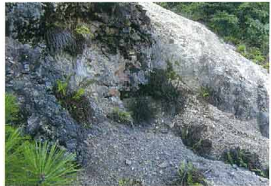
写真6. 崩落により入口が閉ざされた廃坑 (和気郡吉永町, 2007年9月26日).
