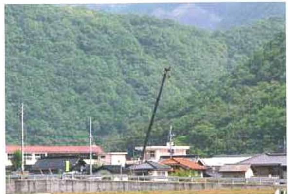
写真28. 稼働するクレーン (2007.2.13)
