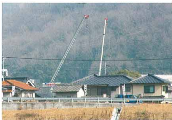
写真20. 稼動するクレーン (2008.5.15)
