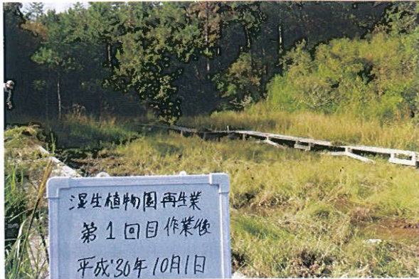
写真3. 乾燥域の表土剥ぎ取り作業後。ススキ、カモノハシが繁茂し、土地が盛り上がり乾燥化しつつあった地盤を剥ぎ取っている。撮影日：2018年10月1日。
