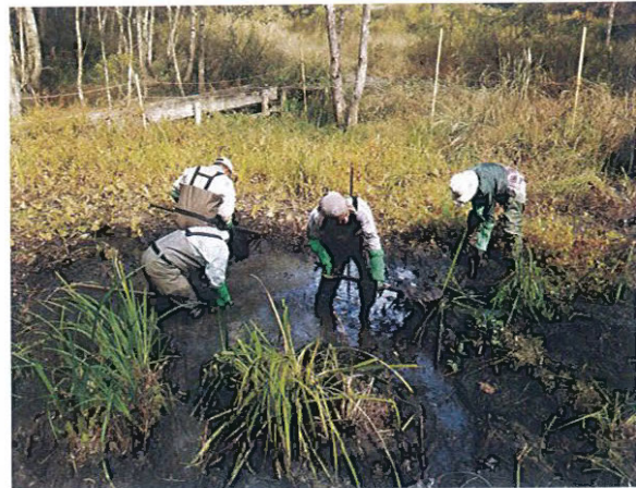
写真5. 池の底浚い作業。土砂がたまって水面が無い状況であったため、浚うというより掘り取っているような状況である。撮影日：2018年11月4日。
