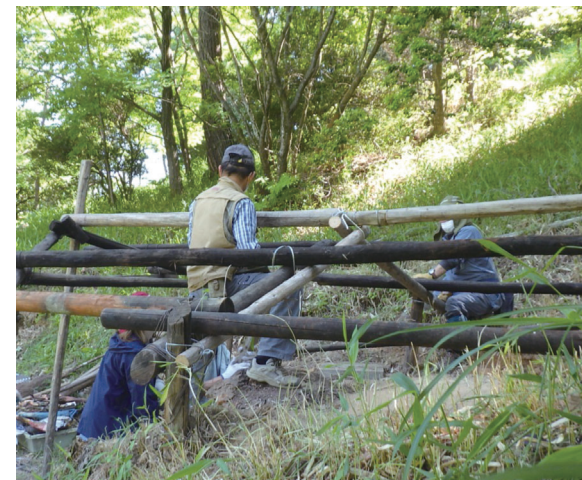
写真2. 炭焼き小屋の屋台骨の修繕 (2022年5月18日撮影)
