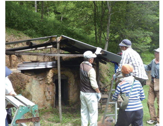
写真3. トタンの入れ替え (2022年7月6日撮影)
