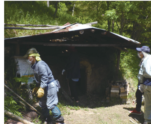
写真1. 修繕前の炭焼き小屋 (2022年5月18日撮影)
